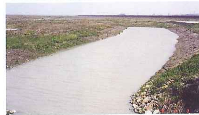
調整池水位が-1.0mで管理されることにより、旧堤防の排水樋門外側（海側）のガタ土が乾燥し、取り除く作業が容易になったため、今では排水が改善されています。
