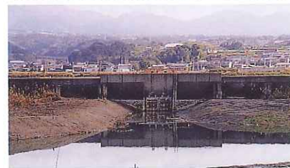
調整池水位が-1.0mで管理されることにより、旧堤防の排水樋門外側（海側）のガタ土が乾燥し、取り除く作業が容易になったため、今では排水が改善されています。
