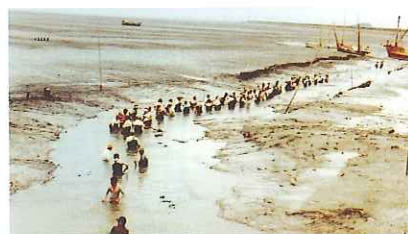
人力によるミオ筋浚渫（重機が入らず重労働）
