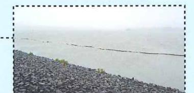
潮受堤防の調整池側（内側） （平穏で高潮被害なし）
