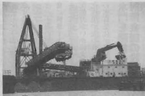
調整池から見た潮受堤防工事。「ギロチン」のようにして閉め切った場所に、巨大なベルトコンベアーと土砂運搬船を投入し、大量の土砂が休日返上で一気に投入された。
