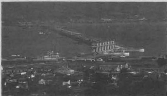
諫早湾の北側から見た長さ7050メートルの潮受堤防全景。堤防手前の施設は北部排水門で、対岸に近い方には「ギロチン」現場と南部排水門がある。堤防の右側には調整池と広大な干潟が広がる。
